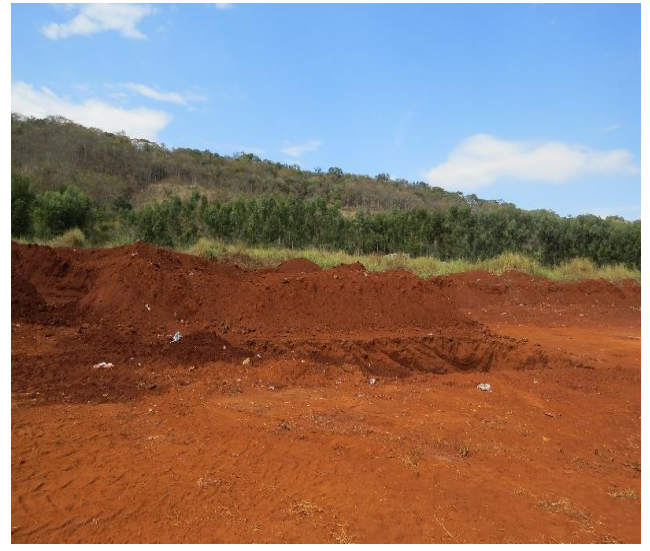
Foto 15. Demonstração de vala aberta, e morro de terra para fechar a mesma. Logo atrás, Eucaliptos plantados sobre as valas já encerradas. Foto tirada em 2021
